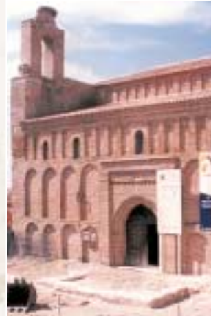
Base correspondiente a un pórtico que existió en la Fachada Sur de la Iglesia.
